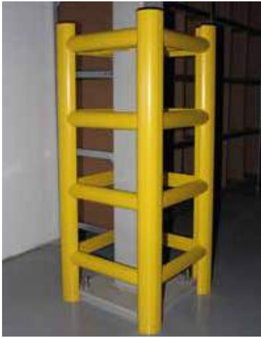
Auch Rammschutz wurde installiert
